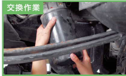
エンジン・オイル・フィルタをエンジンから取り出し中
