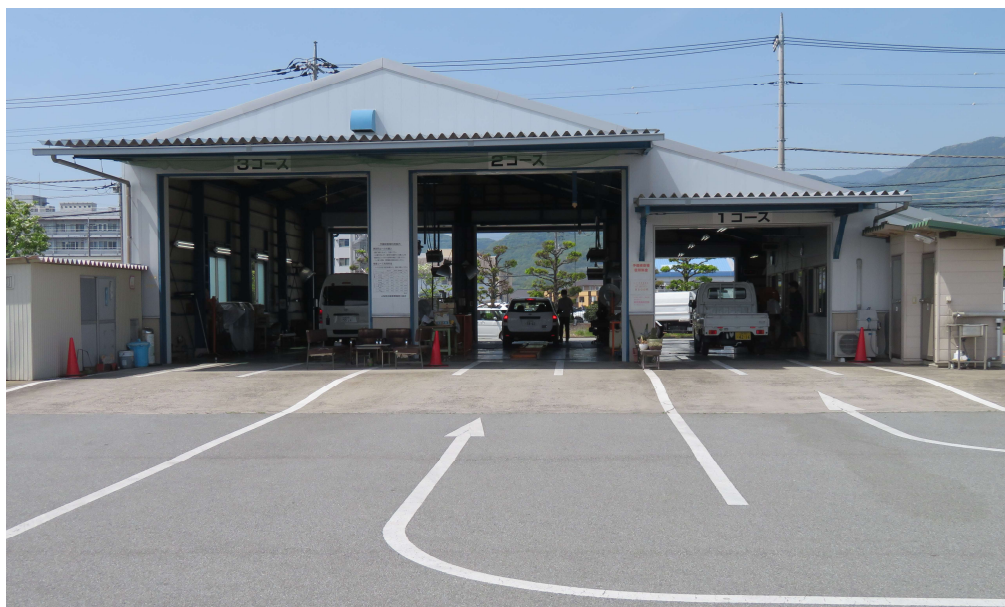
予備検査場の全景
