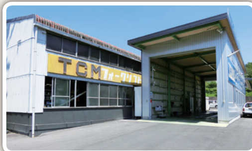
▲大型車両にも対応した建屋が並ぶ
